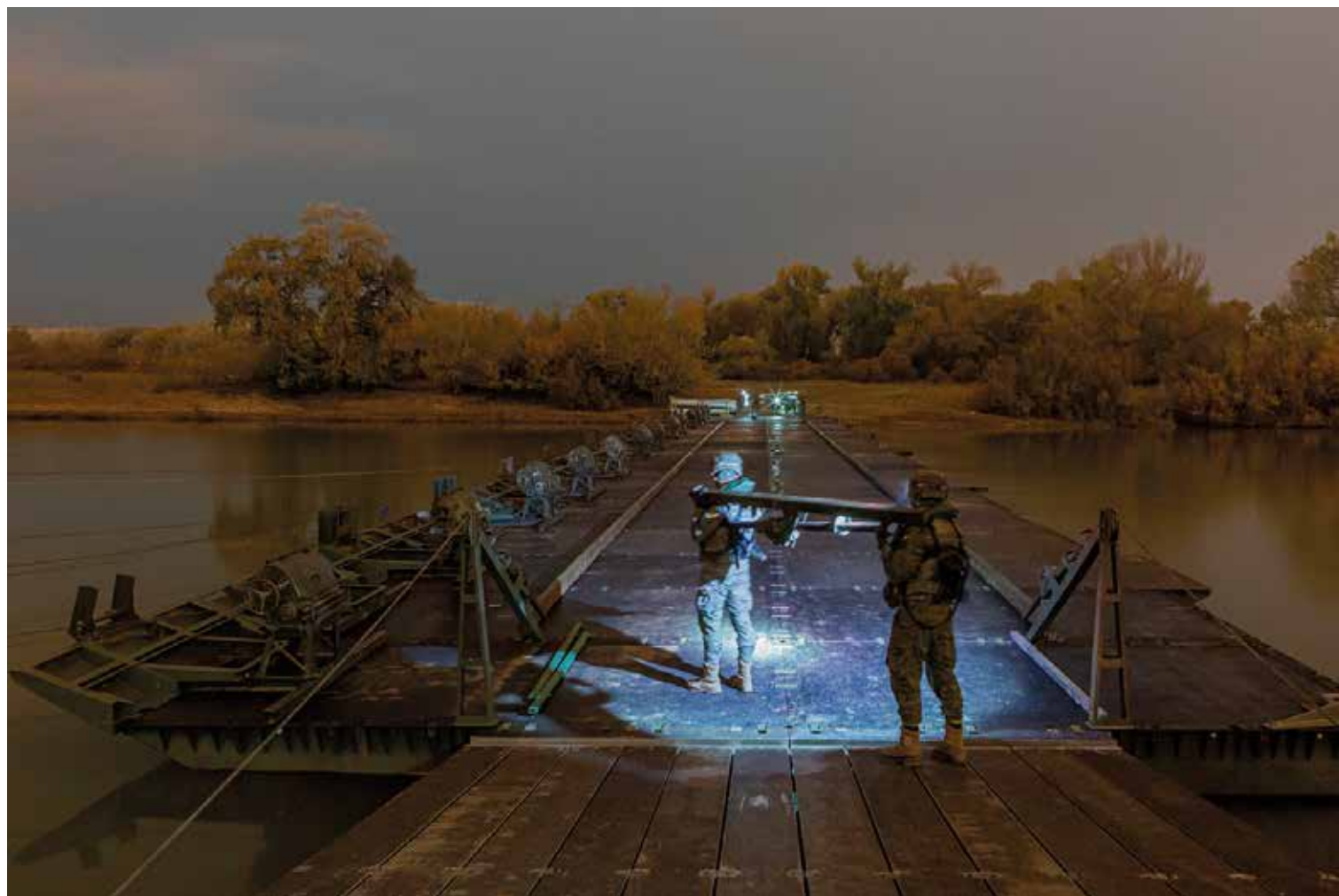
Se establecieron dos puntos de paso, un puente MAN y otro Mabej, en el río Ebro, a la altura del acuartelamiento "Sangenís", del RPEI 12
