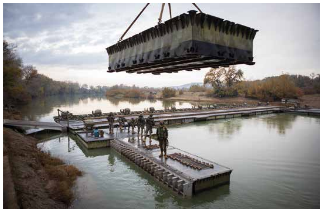
Los alféreces montaron el puente con la ayuda del personal del RPEI 12
